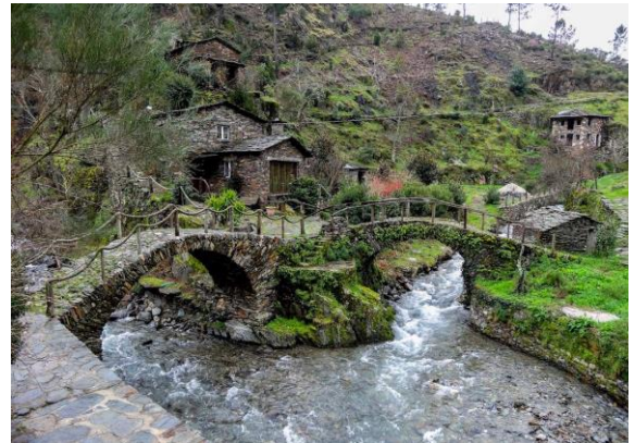
Ponte Foz da Égua, Coimbra
