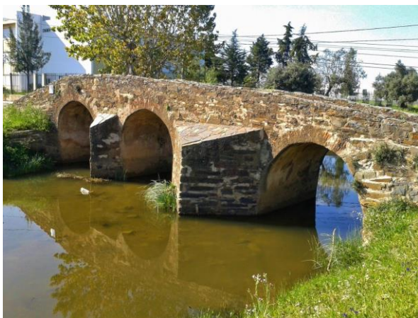
Ponte da Ribeira de Cobres, Beja
