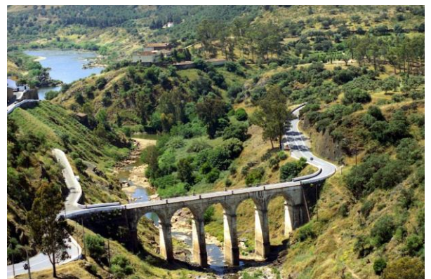
Ponte de Mértola
