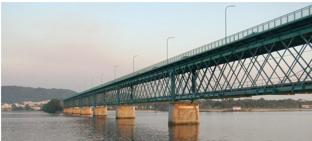
Ponte Eifel – rio Lima – Viana do Castelo
